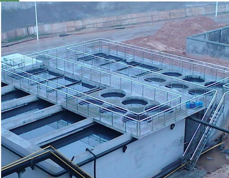
旋流多级浓缩机是集混凝反应过程（“流体力化学”机理）、沉降过程（二次流原理、药剂包裹沉降机理）、深锥浓缩于一体，完成对高浓度微细颗粒分离的全过程。
